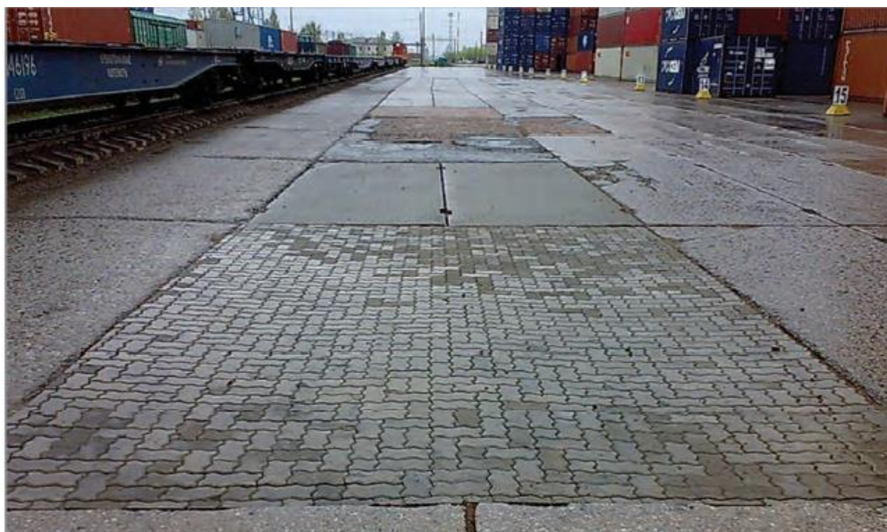
Рисунок 4 – Приклад ремонту із застосуванням каменю «Хвиля»
