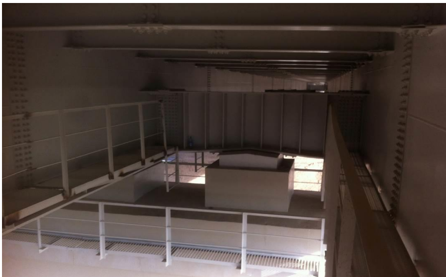
Рисунок 2 – Антисейсмічний прилад на проміжній опорі
