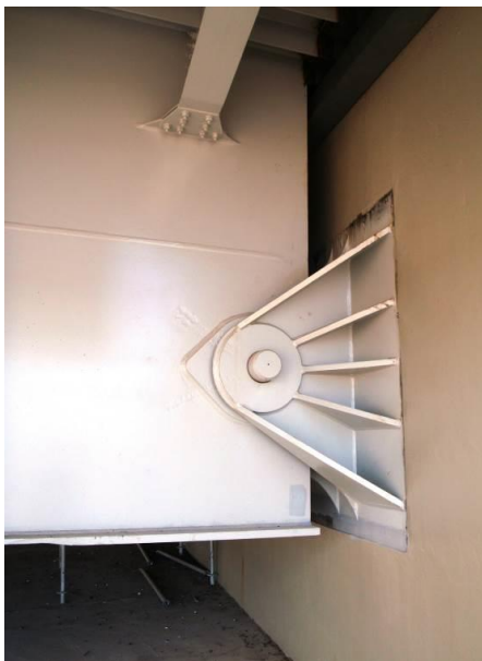
Рисунок 4 – Шарнірний вузол об'єднання прогонової будови та устою
