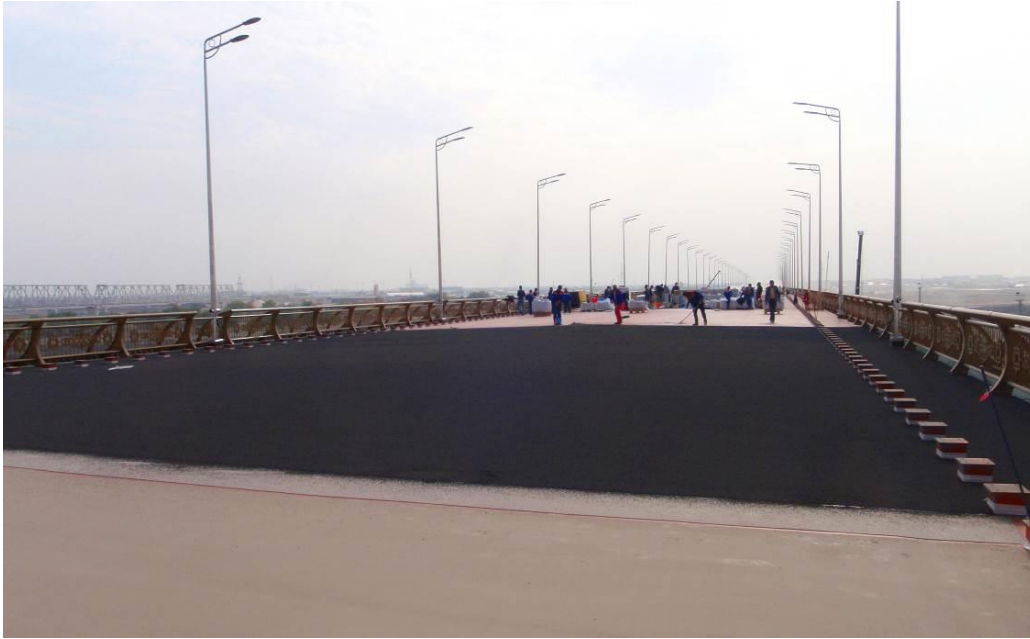
Рисунок 6 – Влаштування покриття BRIDGEMASTER
