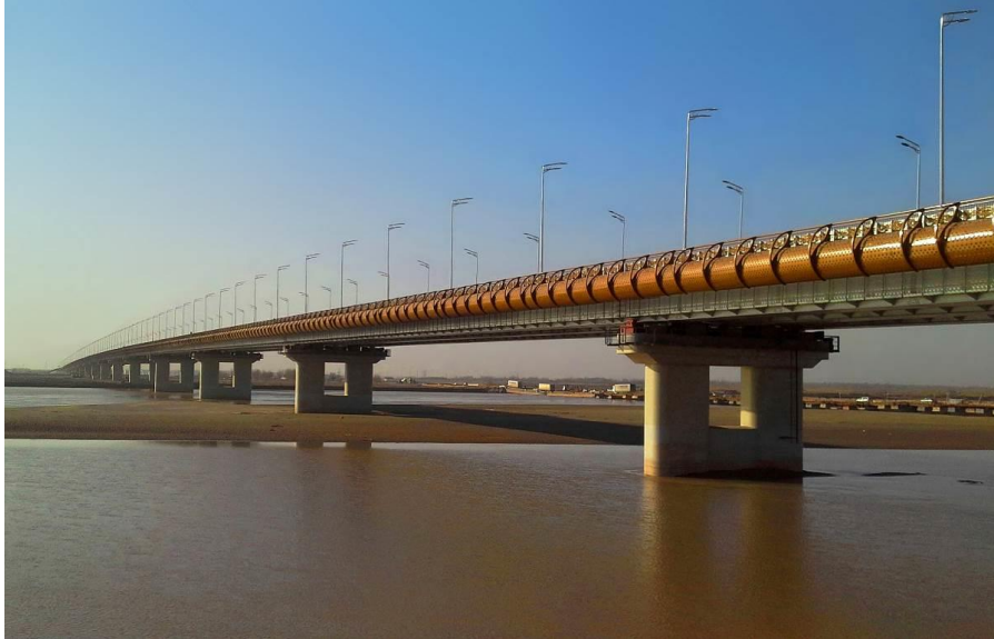
Рисунок 1 – Загальний вигляд моста
