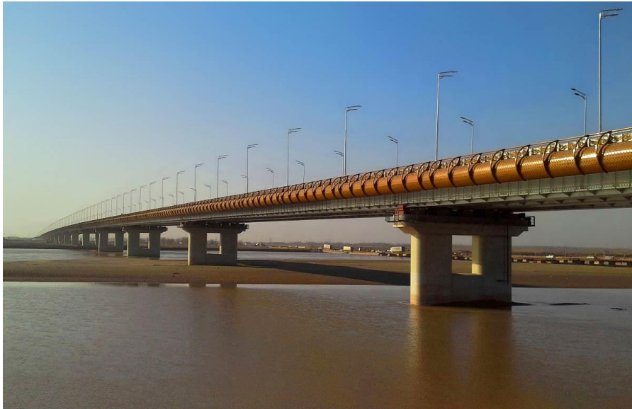
Рисунок 1 – Загальний вигляд моста
