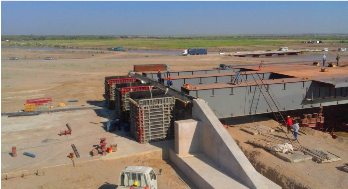
Рисунок 3 – Спорудження устою
