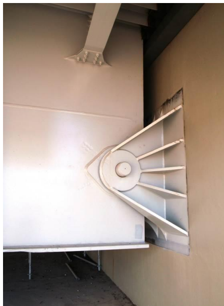
Рисунок 4 – Шарнірний вузол об'єднання прогонової будови та устою
