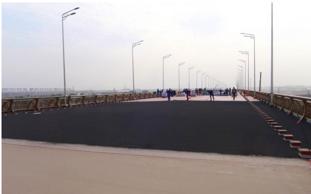
Рисунок 6 – Влаштування покриття BRIDGEMASTER
