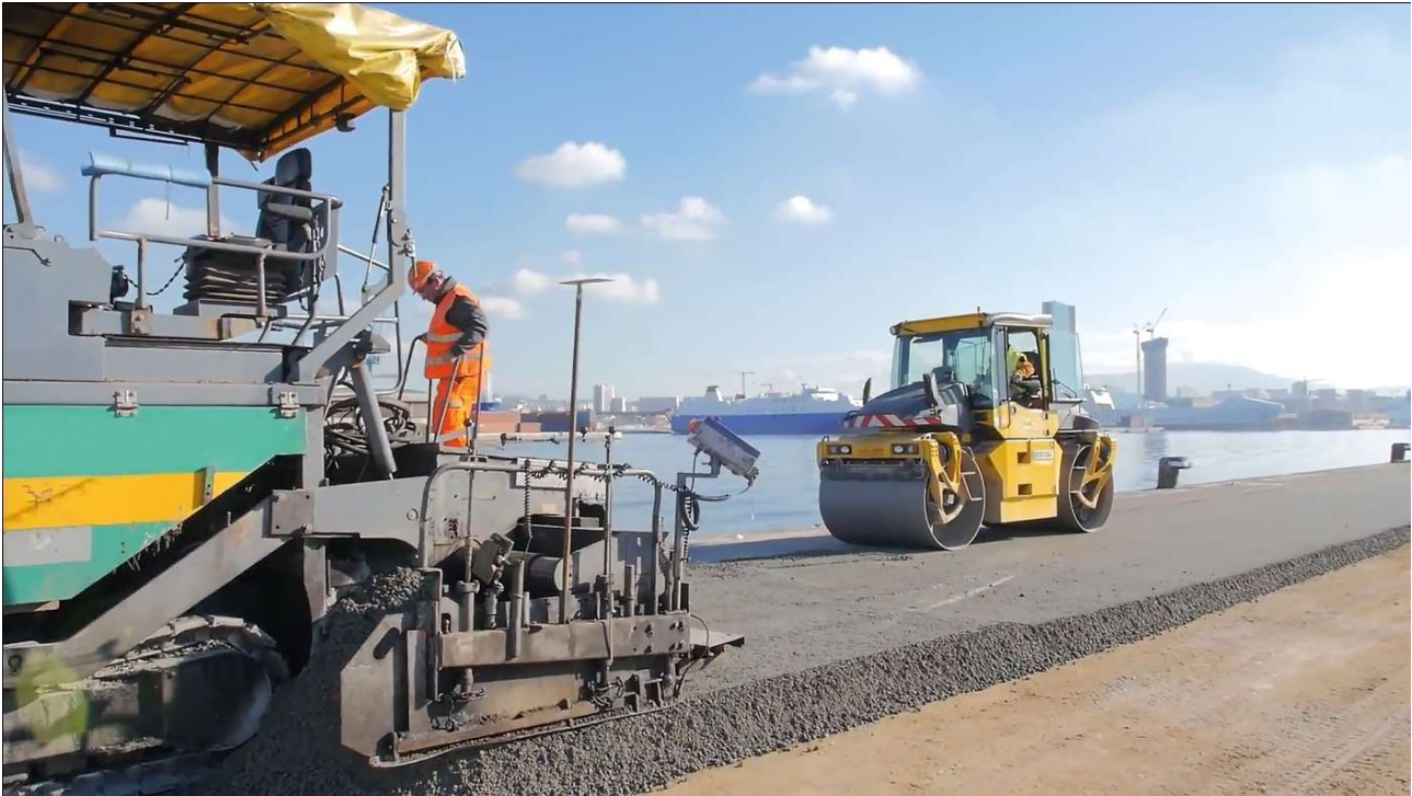
Figure 3 – Roller compacted concrete application Рисунок 3 – Влаштування покриття з укоцovanого цементобетону
