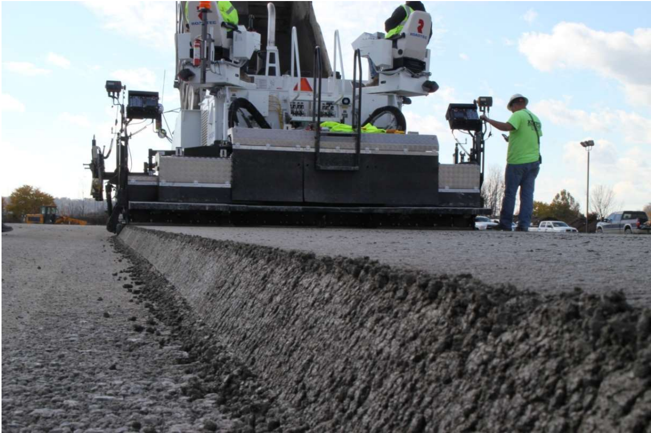
Figure 1 – Rolled extra stiff concrete pavement application with an asphalt paver with edge shaping Рисунок 1 – Влаштування покриття з укочуваного наджорсткого цементобетону з формуванням кромки асфальтоукладальником
