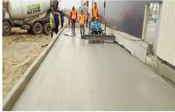
Рисунок 2 – Прийом цементобетонної суміші в захватку. Відсутність розшарування суміші.
