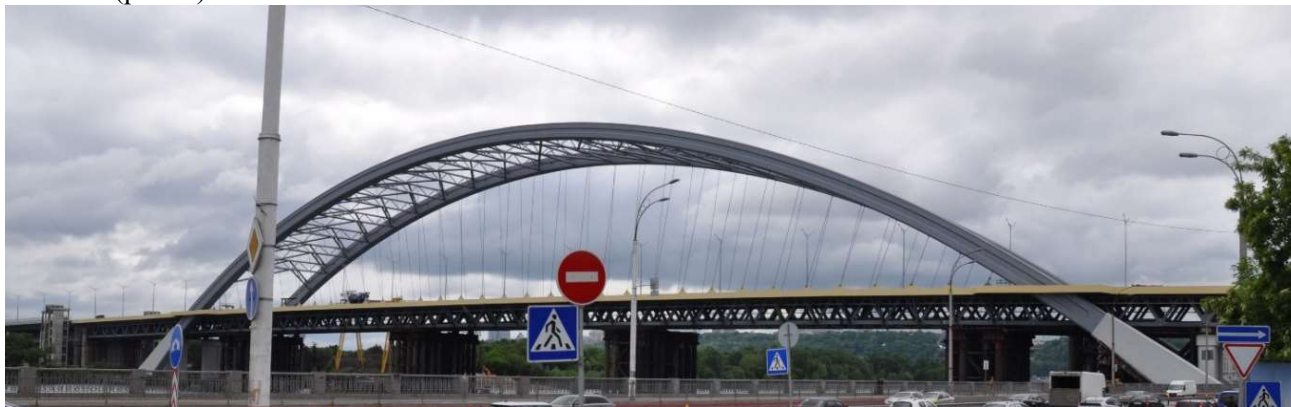
Рисунок 2 – Арковий міст через р. Дніпро є частиною Подільського мостового переходу у м. Києві
