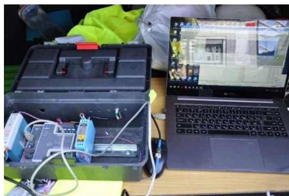
Рисунок 3 – Загальний вигляд обладнання вимірювання та фіксації коливань підвісних канатів
