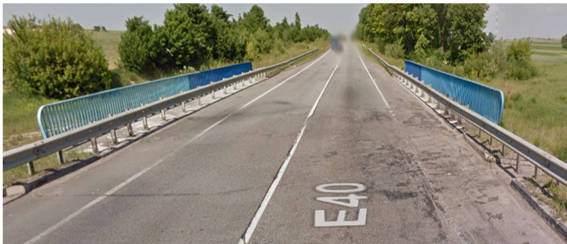
Рисунок 4 – Міст через р. Стубла, км349+580 – км349+605
