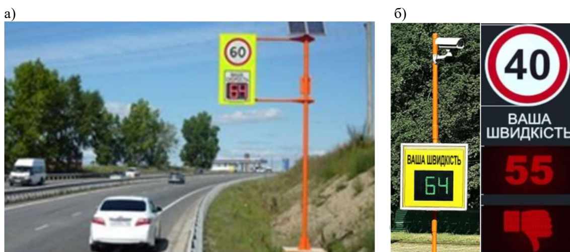
Рисунок 8 – Система інформування учасників руху про порушення швидкісного режиму зворотного зв'язку: а – поєднаного зі знаком 3.29; б – самостійно застосований
