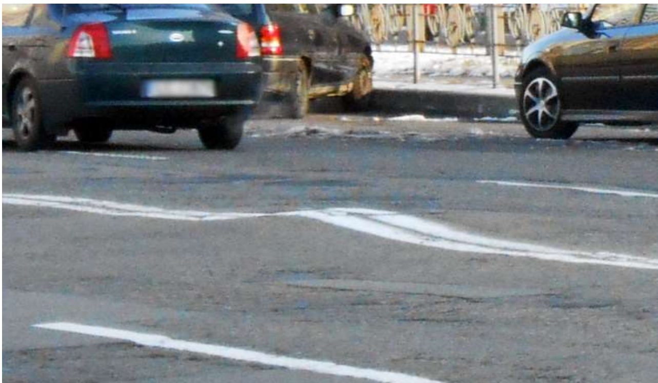
Рисунок 2 – Дорожнє покриття з нерівністю гармонічного профілю [1] Figure 2 - Road surface with harmonious profile irregularities [1]
