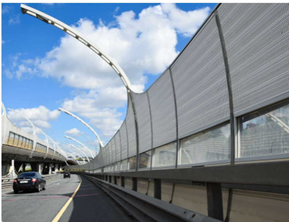
Рисунок 6 – Шумозахисний екран з композитних матеріалів.
