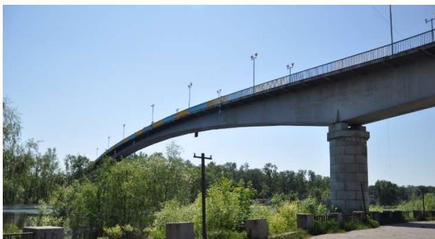
Рисунок 10 – Загальний вид пішохідного мосту
