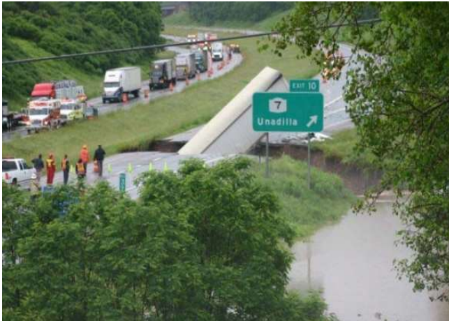
Рисунок 2 – Аварія на автомобільній дорозі I-88 Figure 2 – Accident on I-88
