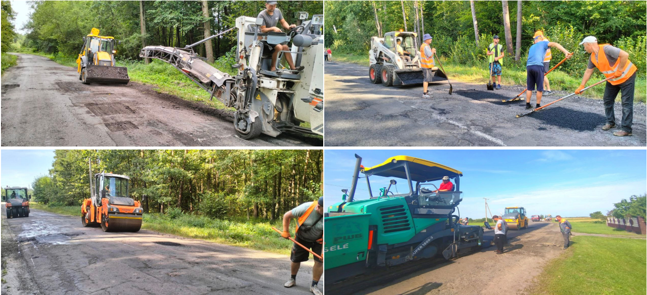
Рисунок 4 – Ліквідація дефектів дорожнього одягу на дорозі Т-18-17 (на фото роботи виконує ПрАТ «Рівнеавтошляхбуд», серпень 2024р.)
