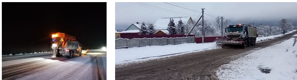
Рисунок 3 – Очищення від снігу та розподілення протижеледних матеріалів на дорозі Т-18-17 (на фото роботи виконує ПрАТ «Рівнеавтошляхбуд», січень 2024р.) Figure 3 – Clearing the road from snow and distribution of anti-icing materials on the highway T-18-17
