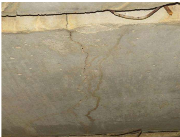
Рисунок 3 – Поперечні тріщини секції водопропускної труби Figure 3 – Transverse cracks in the culvert section
