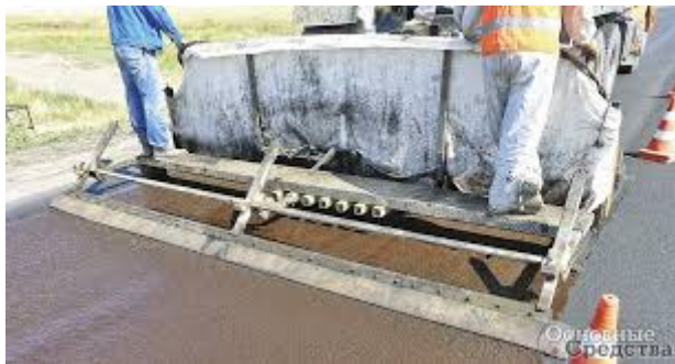
Рисунок 4 – Влаштування покриття ЛЕМС
