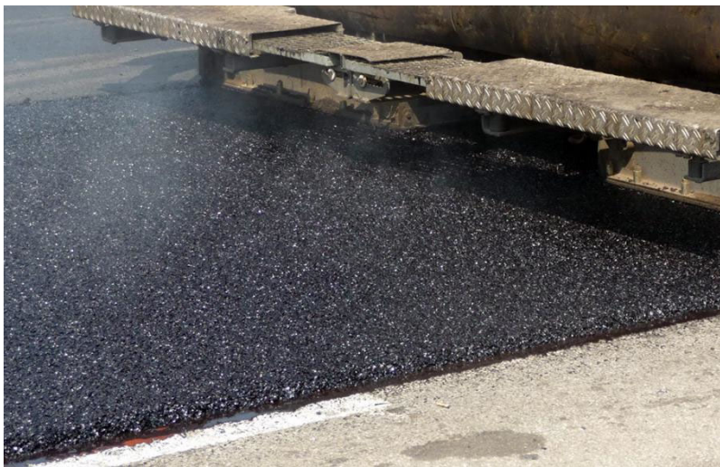
Рисунок 5 – Влаштування тонкого шару зносу із гарячої щебенистої асфальтобетонної суміші.
