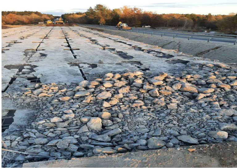
Рисунок 7 – Розбирання існуючого мосту. Figure 7 – Dismantling of the existing bridge.
