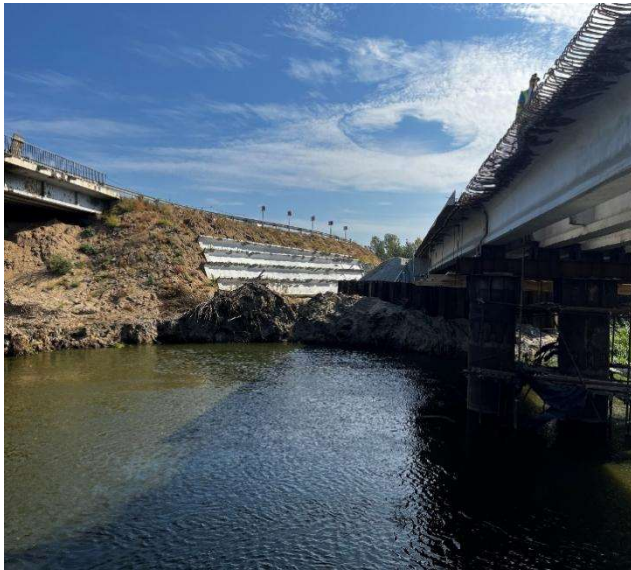
Рисунок 11 – Використання балок ВТП-15 для укріплення конусу тимчасового об'їзду. Figure 11 – Using VTP-15 beams to reinforce the temporary detour cone.
