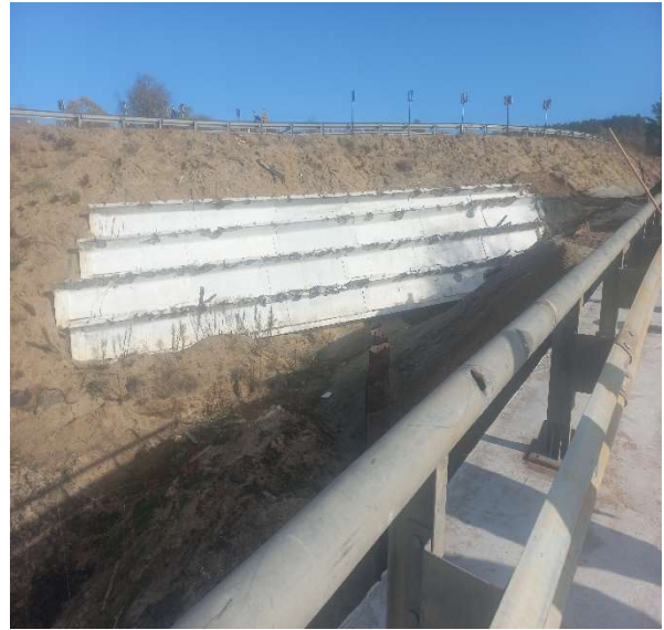
Рисунок 11 – Використання балок ВТП-15 для укріплення конусу тимчасового об'їзду. Figure 11 – Using VTP-15 beams to reinforce the temporary detour cone.
