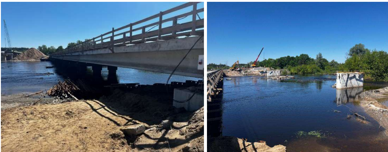
Рисунок 3 – Будмайданчик під час високого паводку. Figure 3 – Construction site during high flood.
