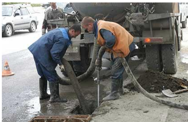
Рисунок 1.11 – Прочистка колодязя зливової каналізації
