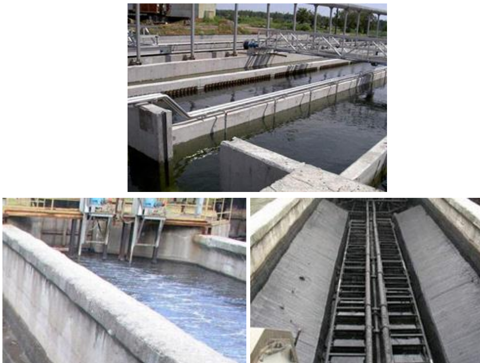
Рисунок 1.9 – Загальний вигляд промислового пісковловлювача
