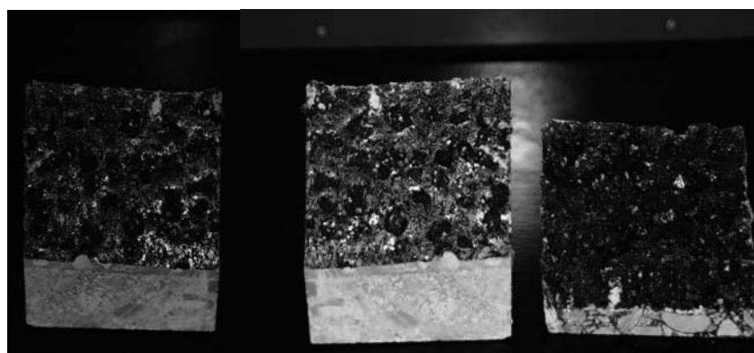
Рис. 4. Характер разрушения системы дорожной одежды №3
