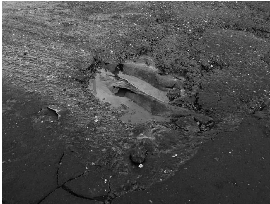
Рис. 1. Состояние дорожной одежды и гидроизоляция на мосту через реку Ликова.
