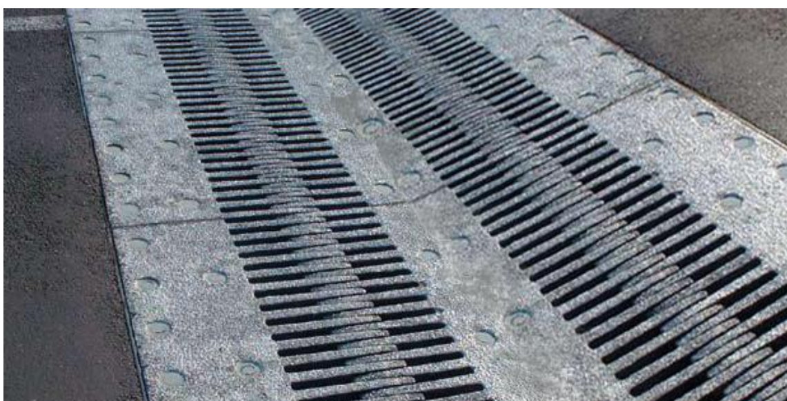
Рисунок 4 - Фрагмент ДШ в плане с гребенчатой плитой с консольными двусторонне направленными пальцами
