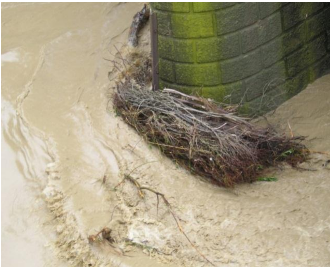
Рисунок 1 – Мостові опори під час паводка зазнають значного гідродинамічного тиску і ударів від плаваючих предметів (р. Прут, м.Чернівці)
