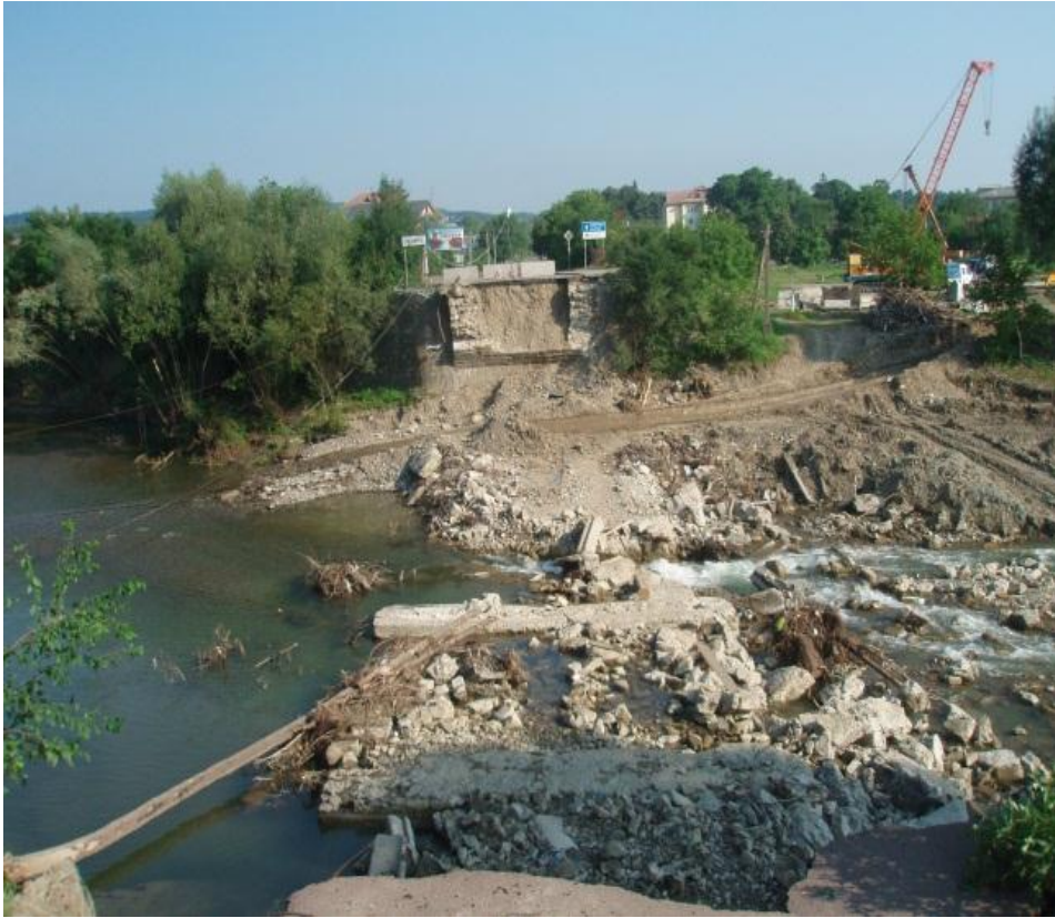
Рисунок 6 – Зруйнований міст через р. Рибниця у м. Косів (2008 р.)
