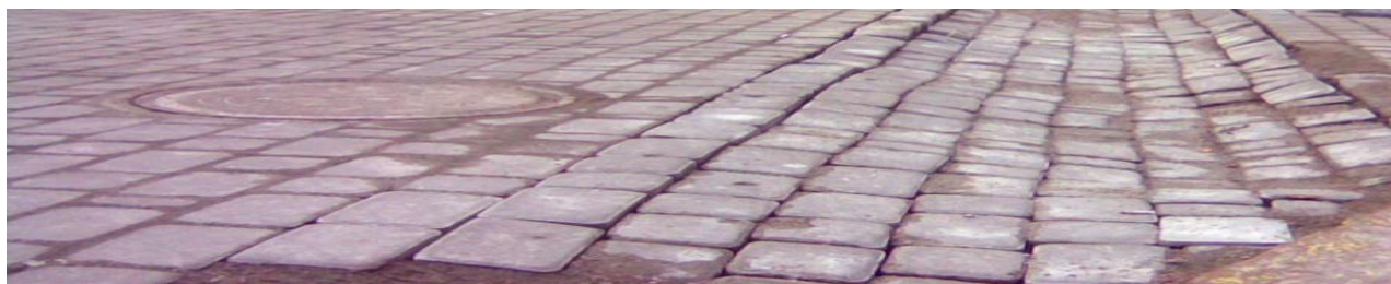
Рисунок 7 – Просідання брукованих покриттів
