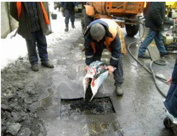
Рисунок 4 - Заповнення виїмки матеріалом аварійного ремонту
