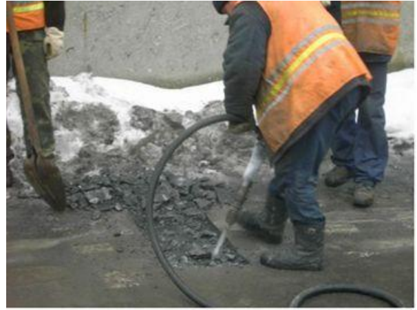
Рисунок 3 - Розробка виїмки за допомогою компресору
