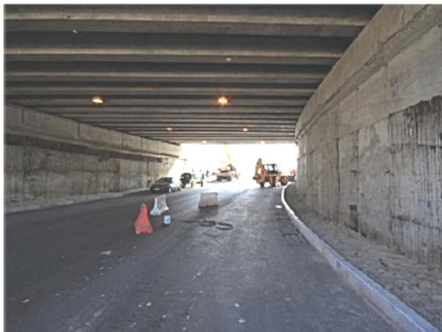
Рисунок 9 – Вид на низ прогонової шляхопроводу тунельного типу розв'язки біля моста Патона
