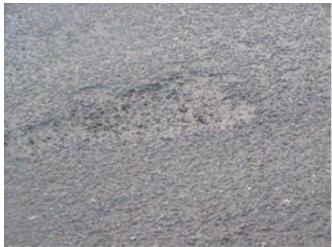
Рисунок 2 – Викришування на покритті із ЩМА викликані недостатньою водо-і морозостійкістю
