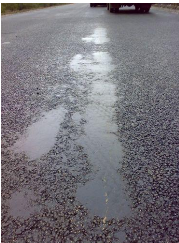
Рисунок 1 – Бітумні плями на покритті
