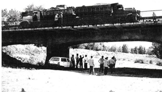
Рисунок 1 - Випробування мосту через р. Ворскла біля с. Білики Кобеляцького району після реконструкції
