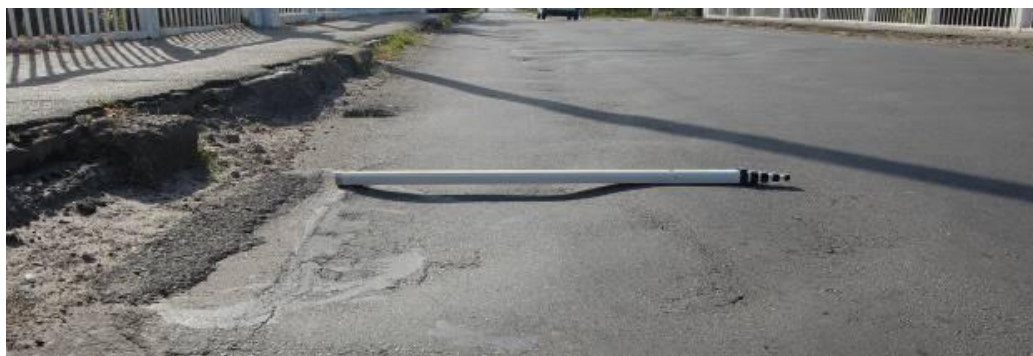
Рисунок 4 – Колійність на проїзній частині мосту (м. Чугуїв)
