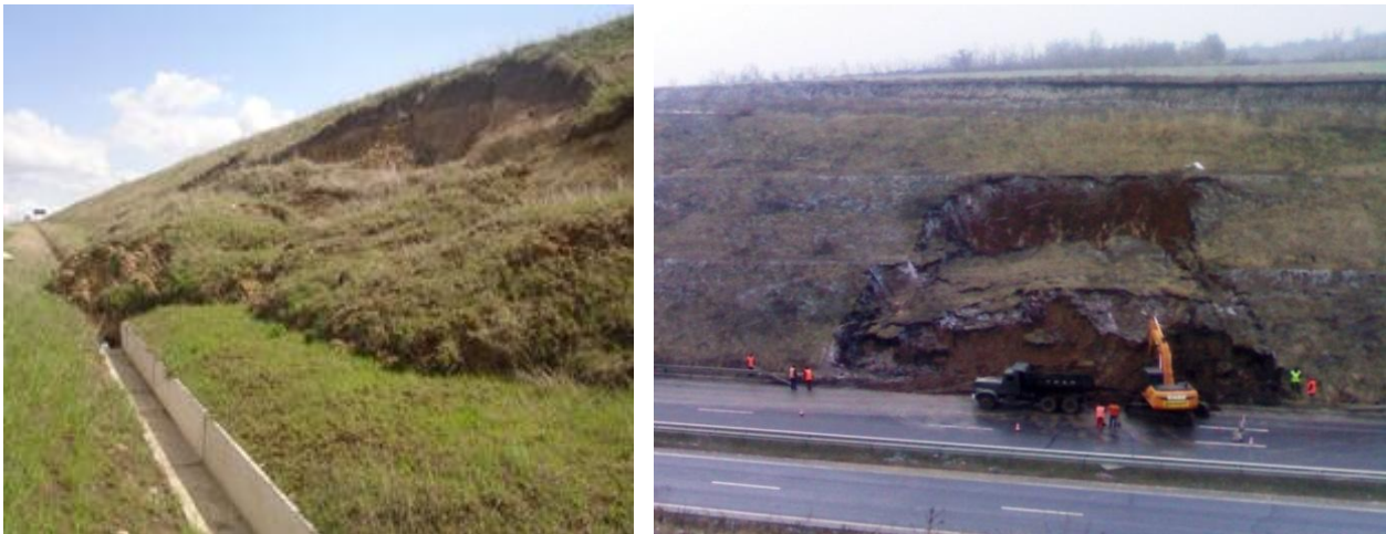
Рисунок 1 – Руйнування укосів виїмок на дорогах України, як наслідок незабезпеченого водовідведення
