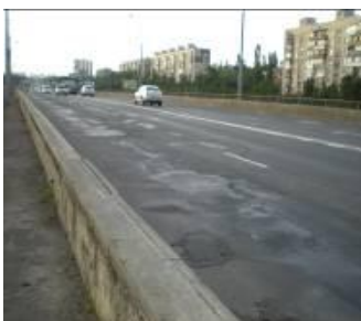
Рисунок 1 – Стан покриття штучних споруд, м. Київ
