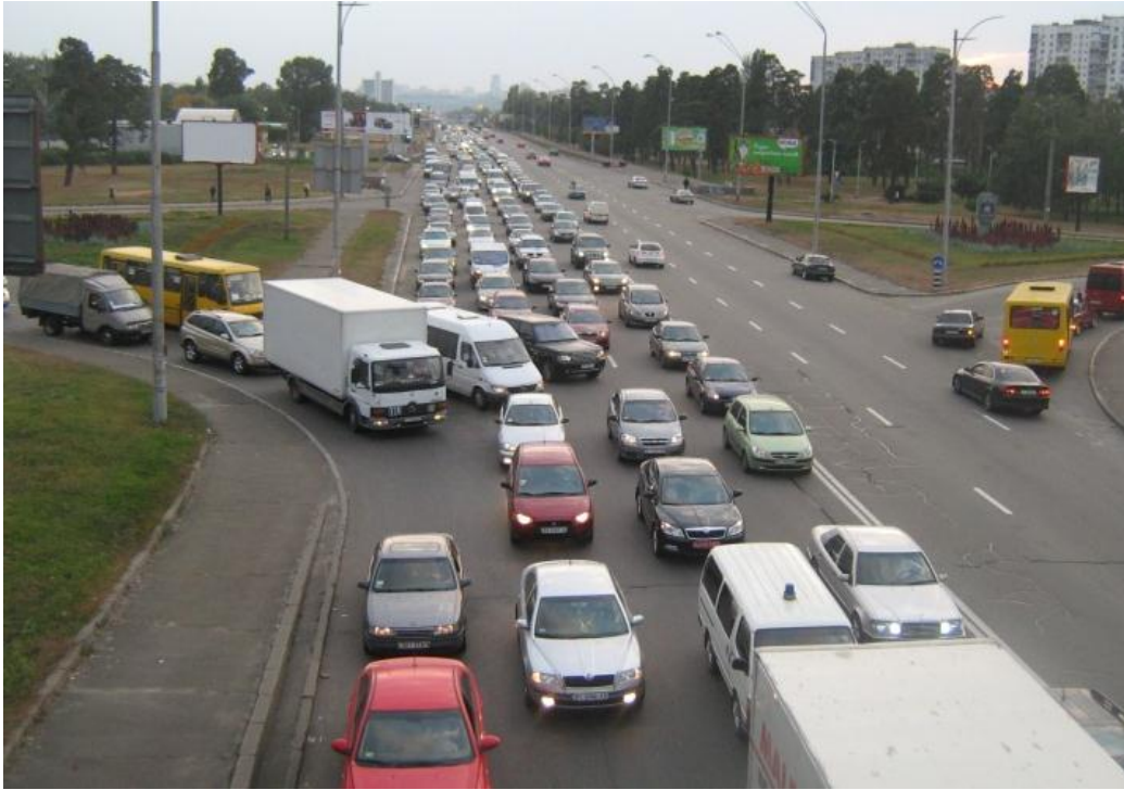
Рисунок 5 – Виїзд з двосмугового з'їзду при відсутності перехідно-швидкісної смуги
