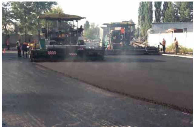
Рисунок 2 – Влаштування асфальтобетонного покриття на ПБВ «Полігум»
