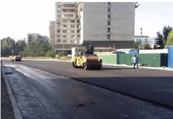
Рисунок 2 – Влаштування асфальтобетонного покриття на ПБВ «Полігум»
