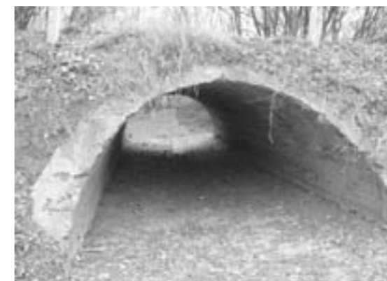
Рисунок 1. Монолітна цементобетонна аркова труба біля ст. Сенча Миргородського р-ну, збудована в 1894 р.
