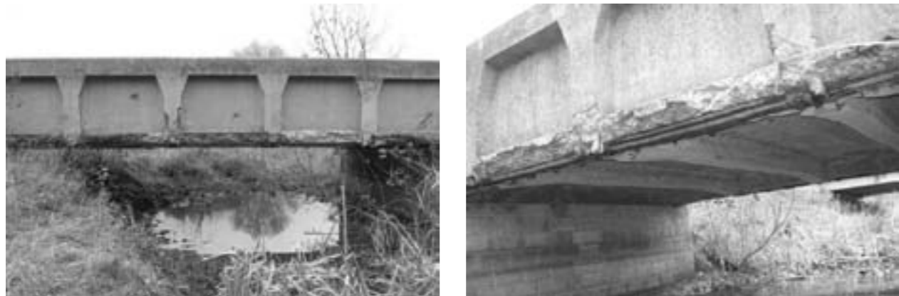
Рисунок 2. Монолітний залізобетонний міст біля с. Ярьськи Шишацького району, збудований в 1908 р.
