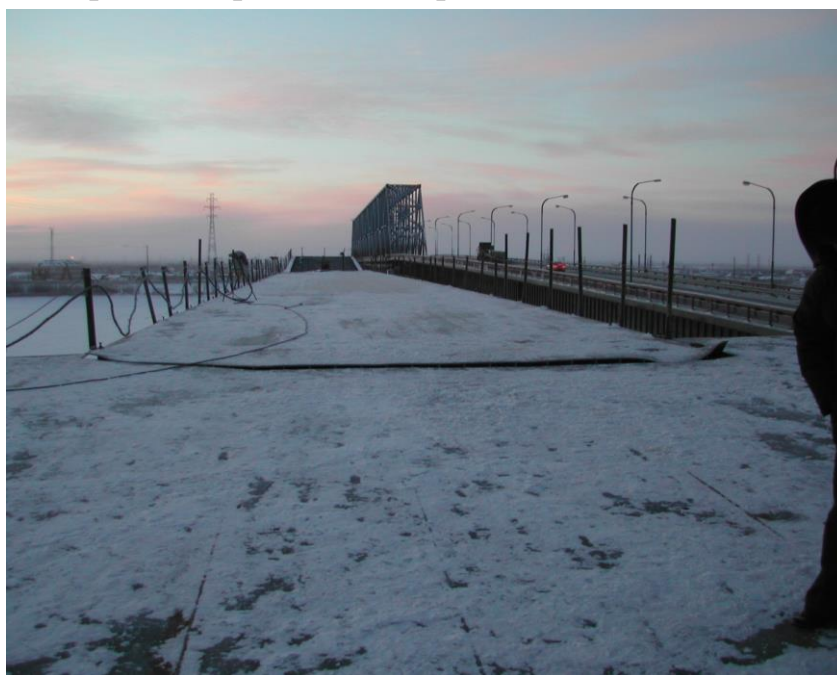
Рисунок 1 – Разрушение пролетного строения моста через Юганскую Обь при надвигке
