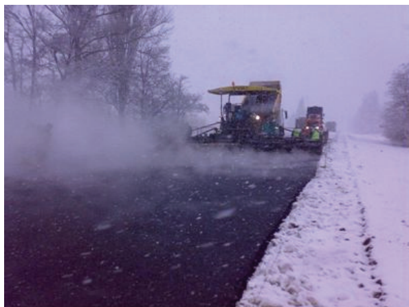
Рисунок 1 – Влаштування асфальтобетонних шарів при мінусових температурах повітря
