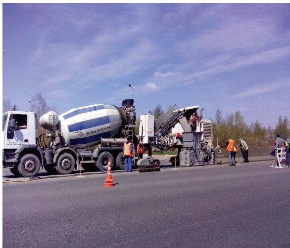
Рисунок 1 – Влаштування парапетного огороження типу «Нью-Джерсі»
