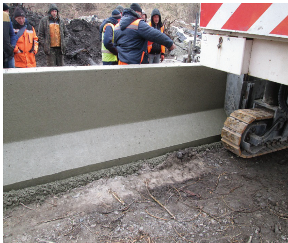
Рисунок 1 – Влаштування парапетного огороження типу «Нью-Джерсі»
