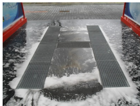
Rys.15. Płyta stanowiska z kratkami ściekowymi [11]
