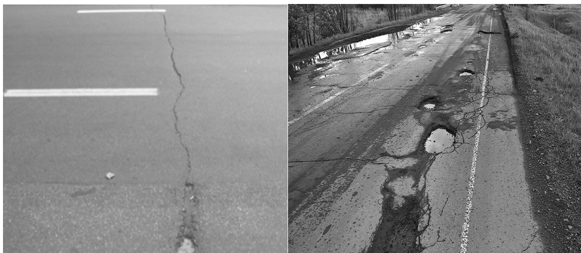
Рисунок 1 – Поперечні і поздовжні тріщини дорожнього покриття Figure 1 – Transverse and longitudinal cracks of the road surface
