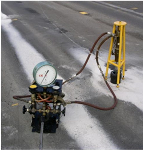
Рисунок 3 – Оцінка зчеплення між шарами дорожнього одягу Figure 3 – Assessment of adhesion between layers of pavement
