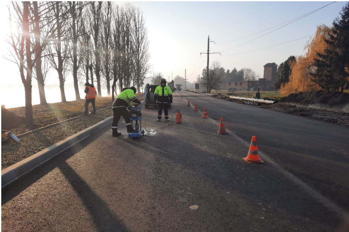
Рисунок 3 – Відбирання зразків-кernів на під'їзній автомобільній дорозі до прохідної 1-го блоку ДТЕК Бурштинської ТЕС Figure 3 – Sampling of core samples on the access road to the passageway of the 1st block of DTEK of the Burshtyn TPP
